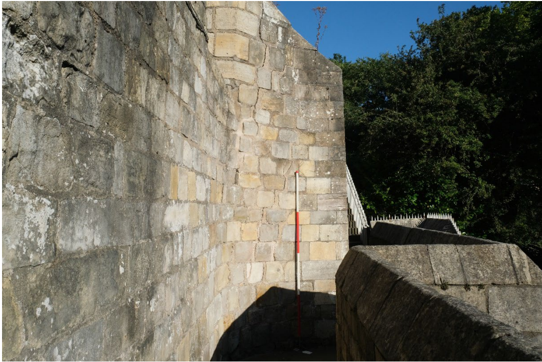
Plate 1 Parapet Wall (2m scale).
